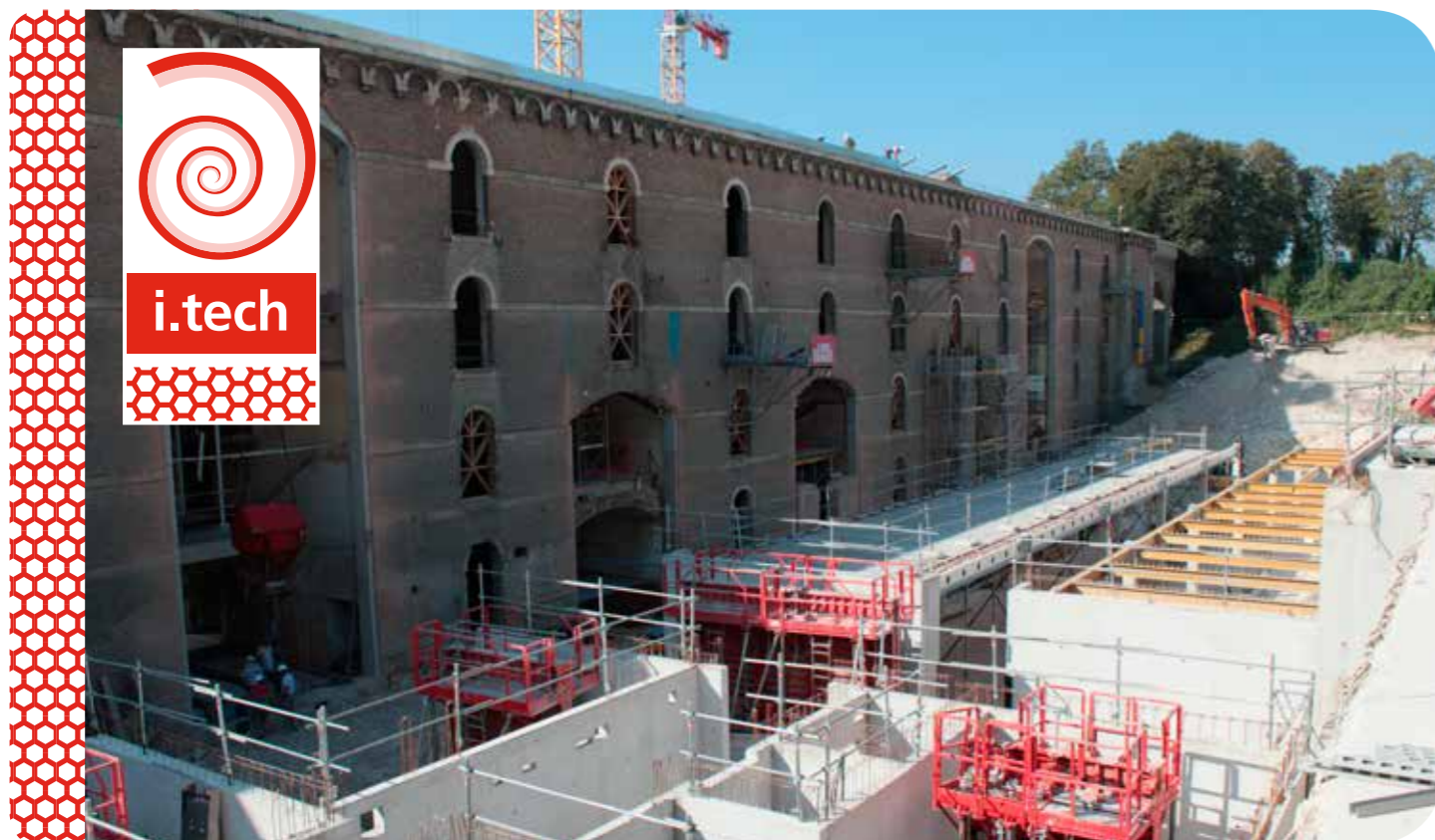
Pôle Universitaire citadelle d'Amiens (80) - Architecte : Renzo Piano Building Workshop.
