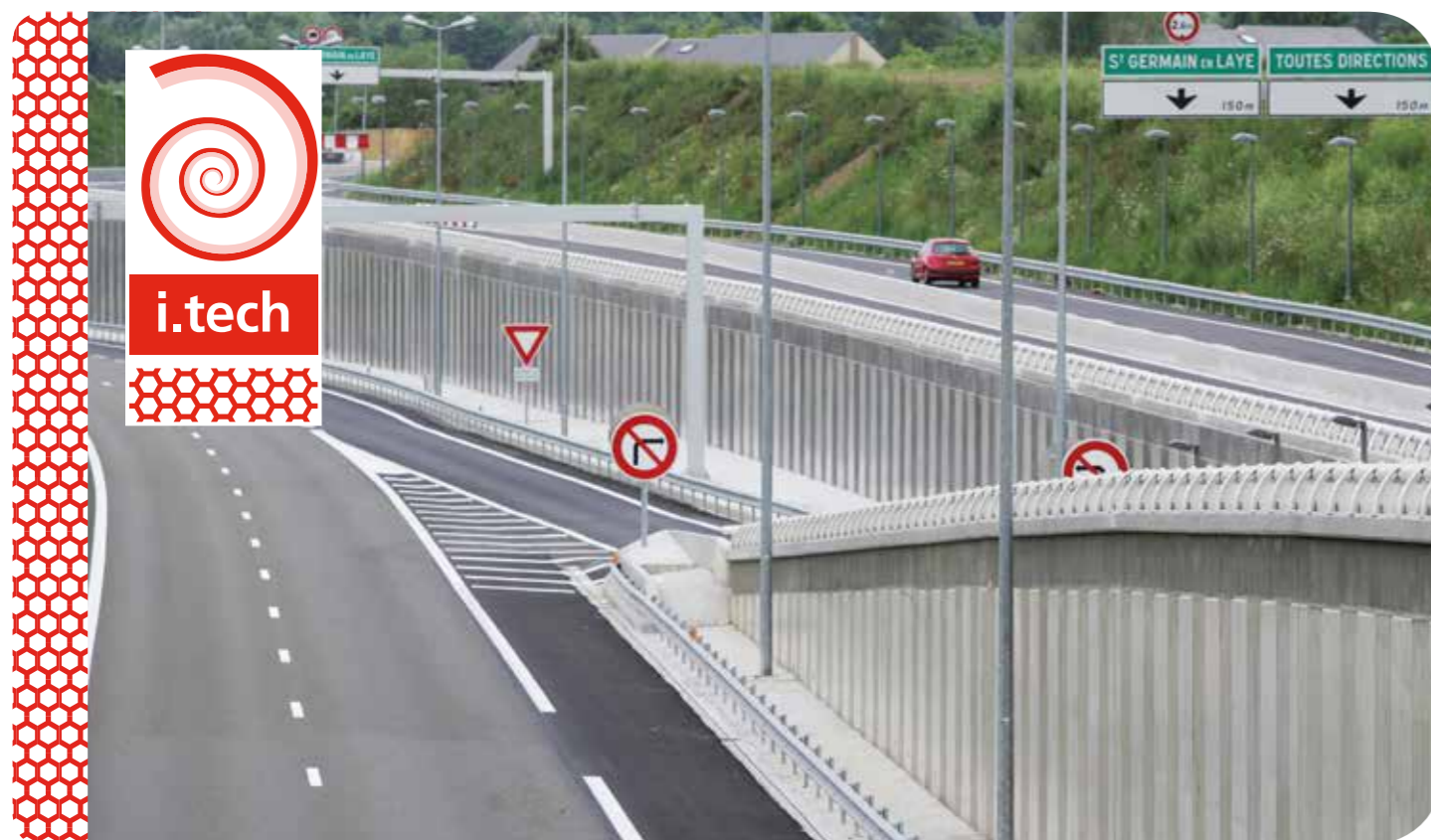
A14 échangeur Chambourcy (78) - Architectes : Charles Lavigne et Alain Montois.
