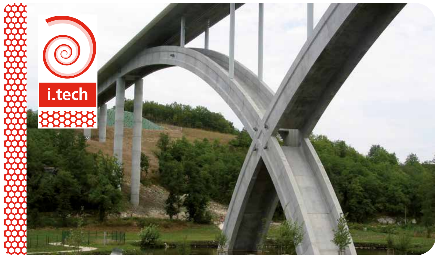
Viaduc de l'Anguienne (16) - Architecte : Charles Lavignec.
