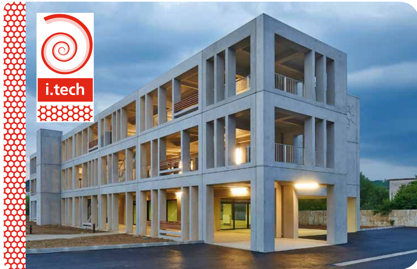
Foyer Emmaüs à Agen (47) - Architecte : Cabinet Hobo.
